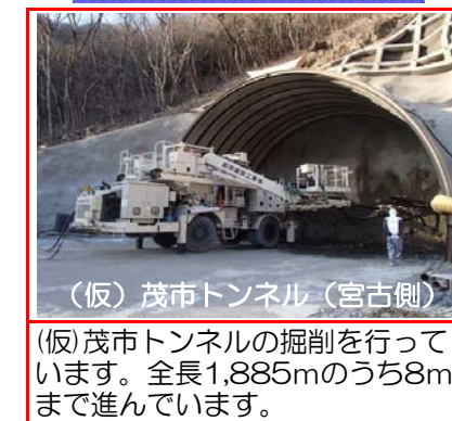
⑥施工：前田建設工業
