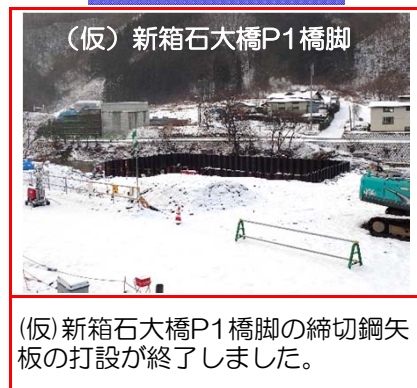
④施工：安藤・間
