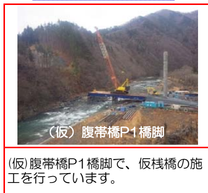
⑨施工：大豊建設
